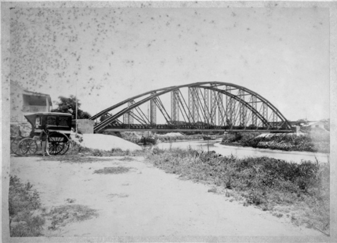
PUENTE DEL FERRO CARRIL A LA ENSENADA
